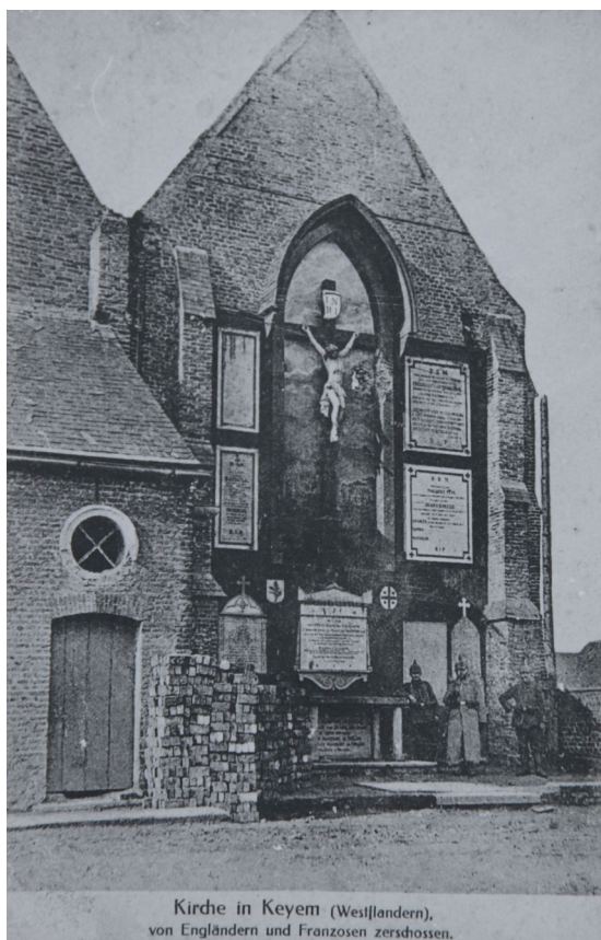
Foto. Prentbriefkaart van de kerk gedurende WO I (bron: Symoen 1980). Bemerkt de grafplaten onderaan de oostelijke kerkmuur, die nog altijd aanwezig zijn. De vier exemplaren links en rechts van het kruisbeeld echter zijn verdwenen.
