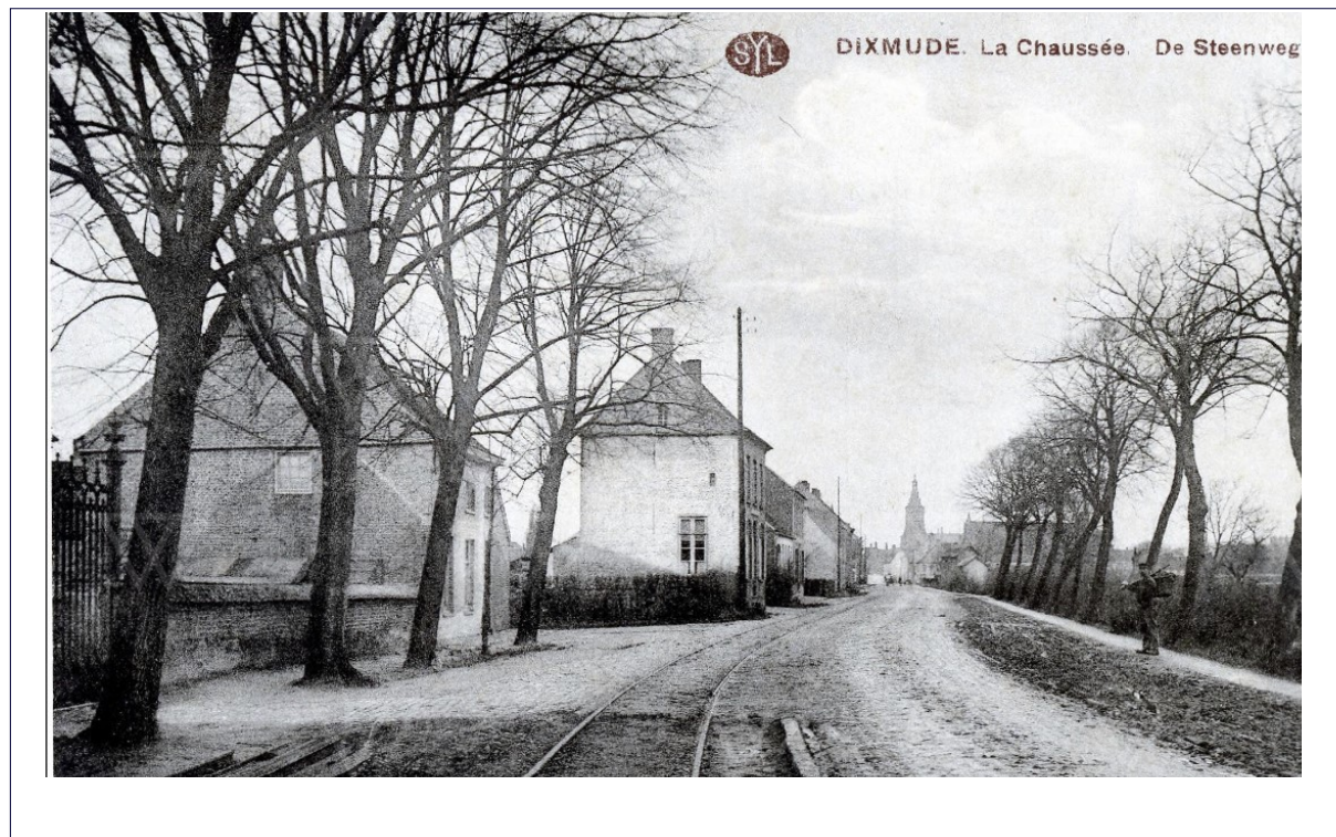
Foto. Toegangshek, kerkhofmuur en huisje van de grafdelver op de begraafplaats van 1785-1918, langs de westzijde van de Woumenstraat, vóór 1914. Bron: Prentbriefkaart Westhoek verbeeldt.be, fotonummer HEUO14505685.
