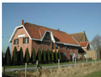
Schoorbakkestraat nrs. 28-30. Voormalig station op de lijn nr. 74. Diksmuide-Nieuwpoort. Deze lijn werd in 1868 opgericht en is sinds 1974 buiten dienst. Het station was opgetrokken in een neoclassicistische baksteenarchitectuur, die vrij gebruikelijk was bij stationsarchitectuur (cf. prentbriefkaart). Tijdens de Eerste Wereldoorlog vormde de * spoorlijn de frontlinie, het station werd in de nacht van 26 op 27 oktober 1914 bestookt door de Duitsers. Het deels vernietigde station werd ingericht als observatiepost. Toen op
